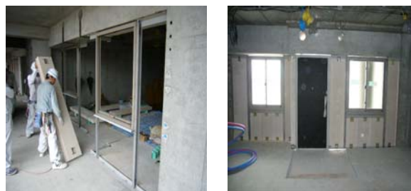
ALC 無溶接工法
